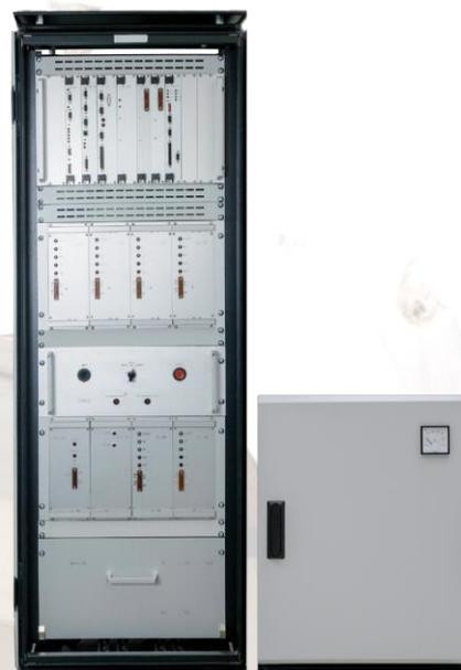
*Цифровой блок управления второго поколения КТМ-2СМ с блоком аккумуляторов*
