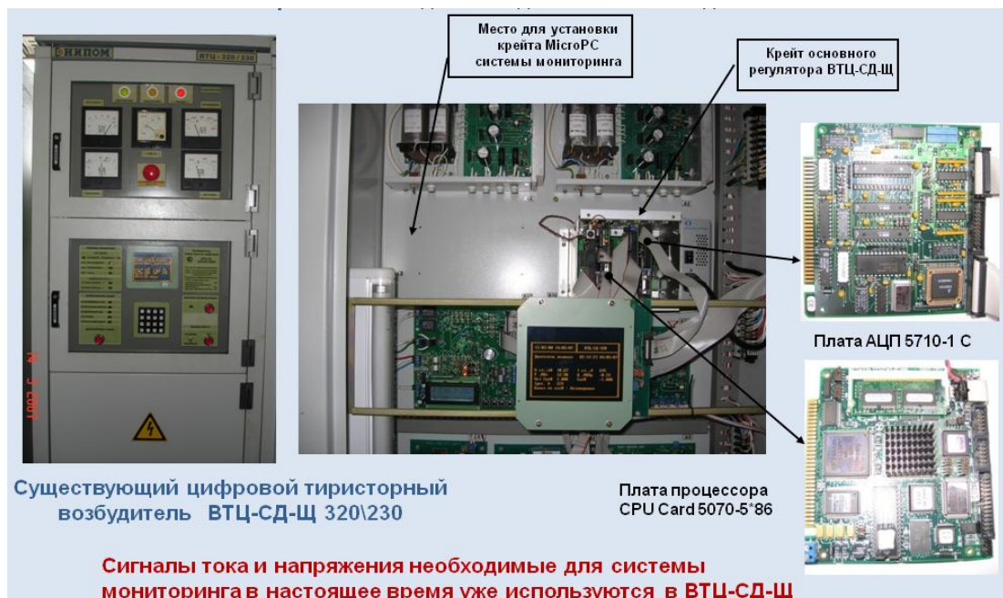
Рис. 6.12. Вариант размещения микропроцессорной системы встроенного мониторинга ЭГПА в шкафу цифрового тиристорного возбудителя.
